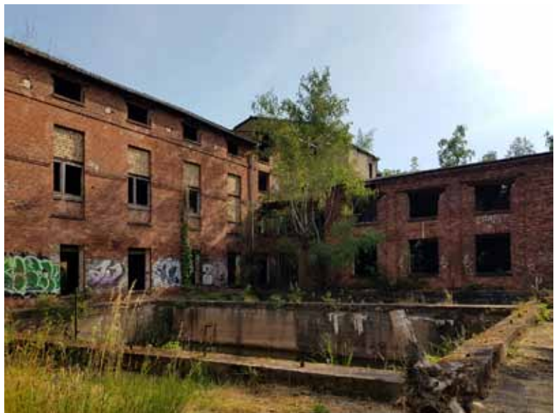
Die alte Konservenfabrik wird saniert
