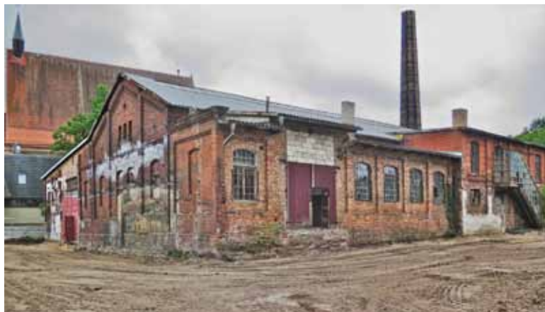
Bestand nach Abbrucharbeiten im August 2022
