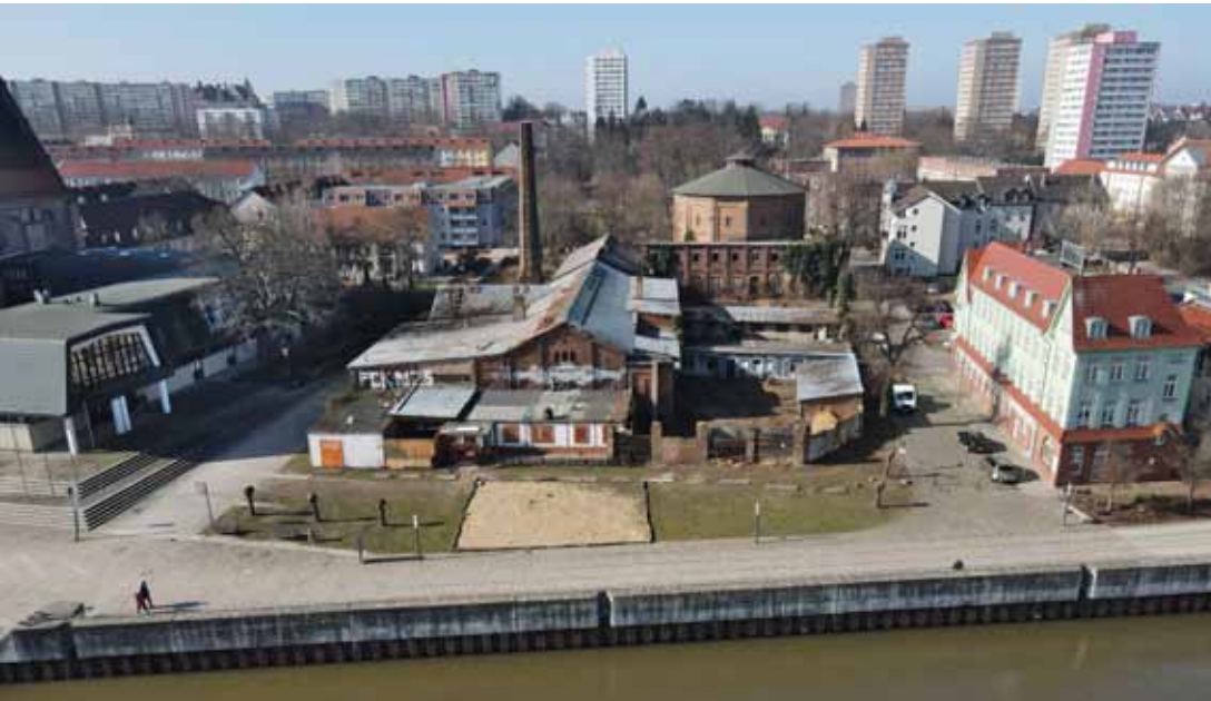
Bestand nach Fällarbeiten im März 2021
