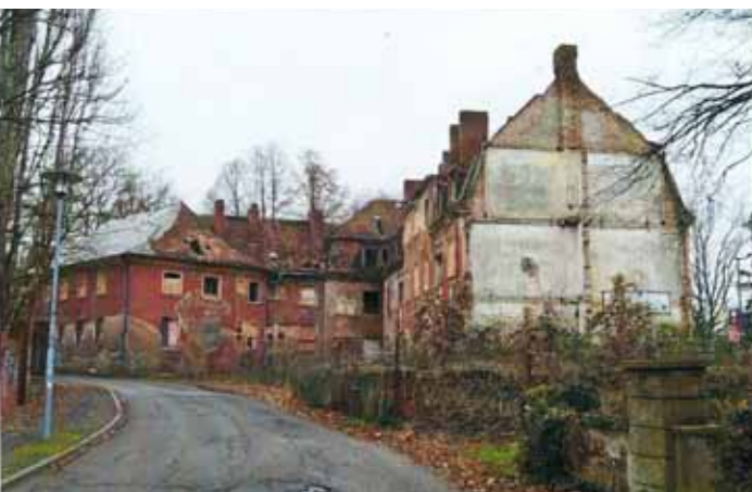
Das Gebäude vor den Bauarbeiten
