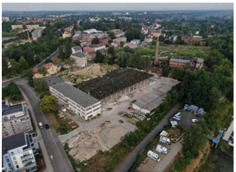
Blick über das Baufeld Richtung Nordwesten vor dem Abriss
