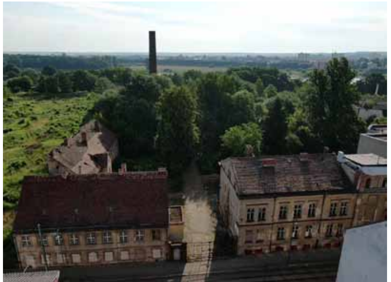
Die historischen Gebäude an der Herbert-Jensch-Straße werden saniert und der Schornstein bleibt erhalten
