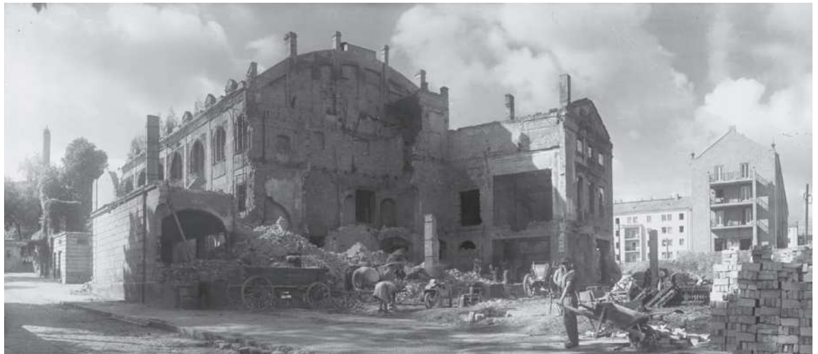
Umbau zum Lichtspieltheater in den 1950er Jahren
