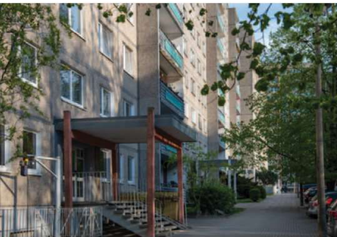
WOHNBAU FRANKFURT Gebäude Allende-Höhe von der Rückseite
