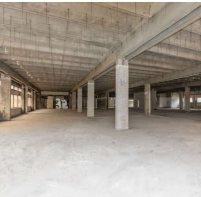
Rohbau des Bereichs der früheren Mensa
