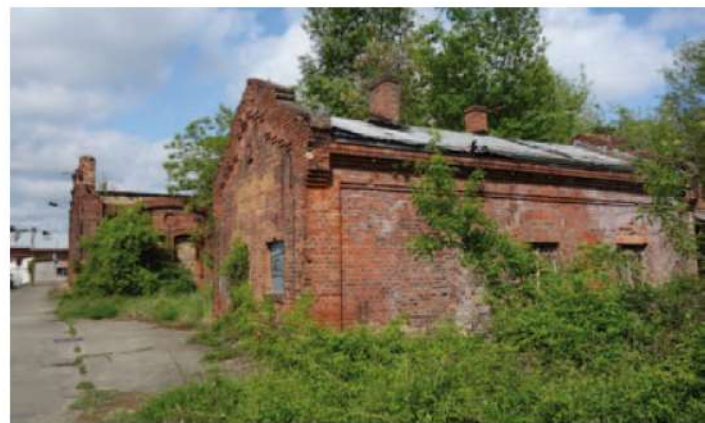
PFE Ruinen auf dem Bahngelände
