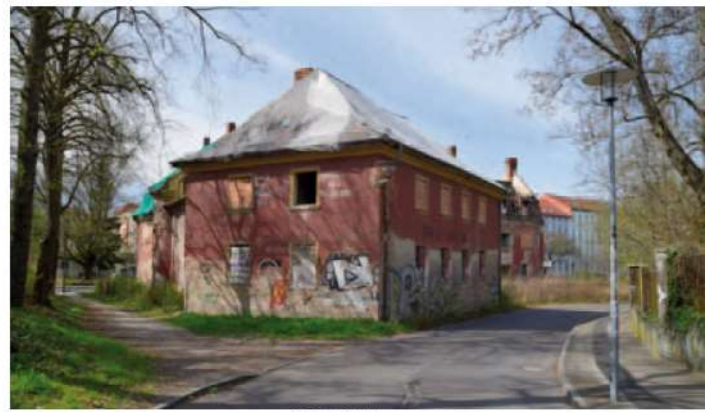
THOMAS WAHL Ruine des Kießlinghauses wird saniert
