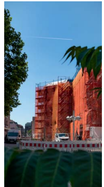
WOHNBAU Die Große Scharrnstr. 8 bei der Sanierung
