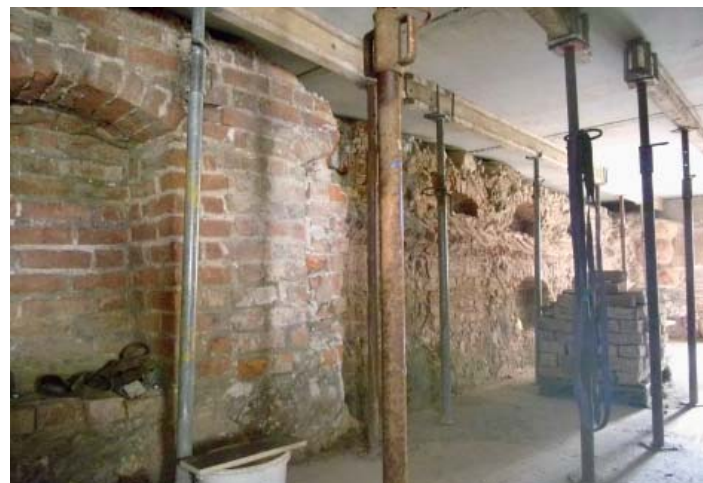
Der bereits mit der Bodenplatte abgedeckte Keller im Vorderhaus der Nr. 12
