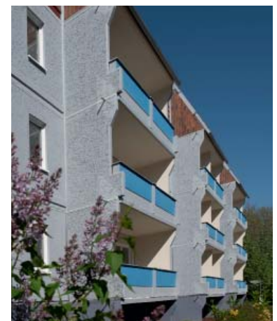
WOHNBAU Saniertes Gebäude in der Schulstraße
