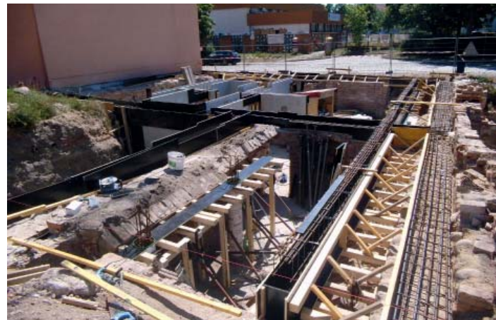
Die ersten Einbauten waren bereits im Sommer sichtbar
