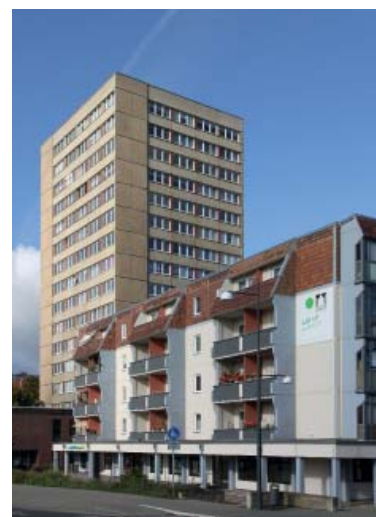
Die Ansicht des Gebäudes wird sich deutlich verändern
