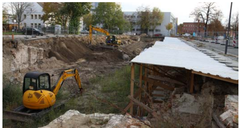
Die Baugrube an der Großen Oderstraße mit den abgedeckten Ausgrabungen
