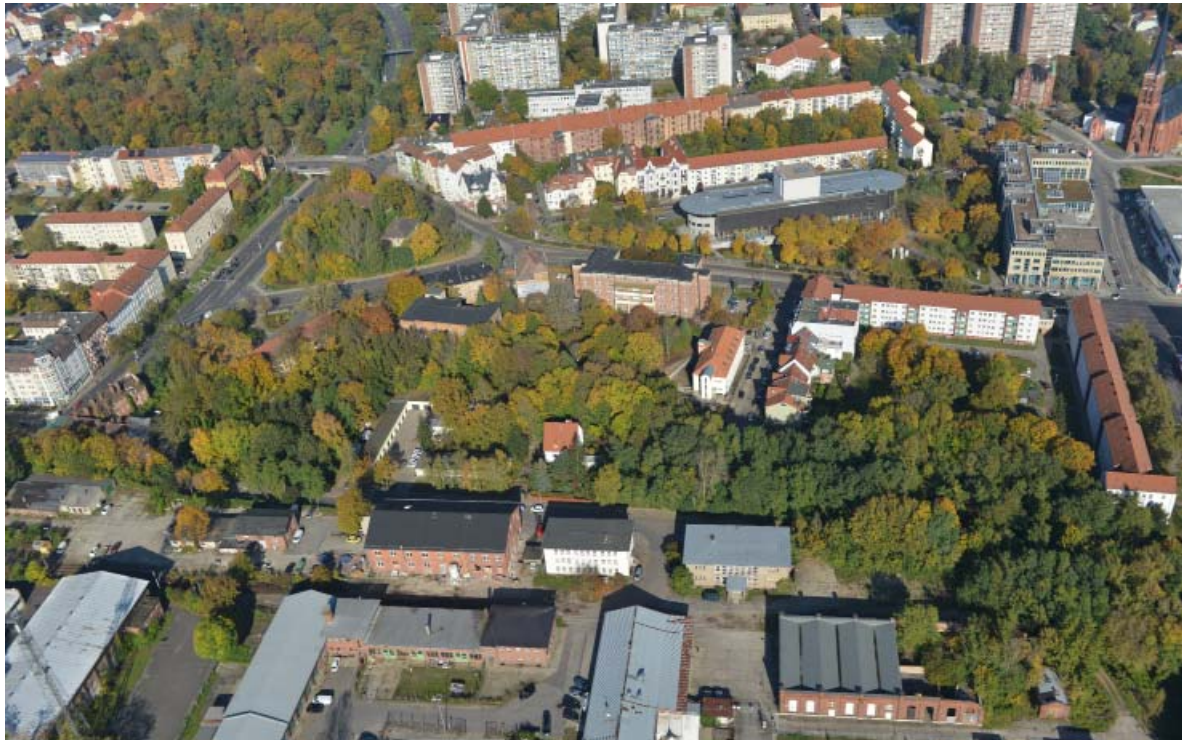
Blick auf das neu beantragte Stadtumbaugebiet an der Heilbronner Straße
