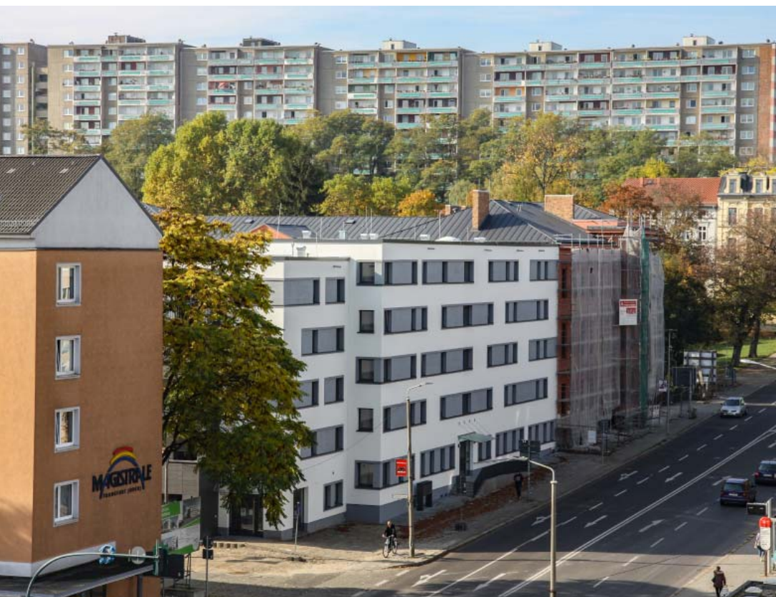
Frisch saniertes Wohngebäude an der Rosa-Luxemburg-Straße
