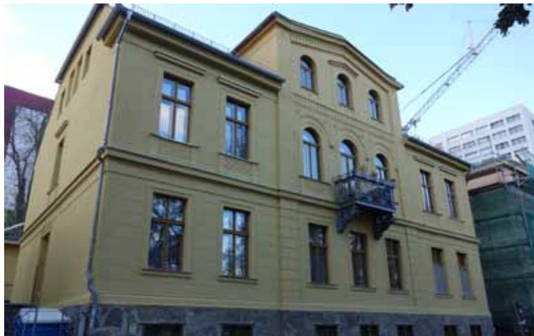
Halbe Stadt 22 - das Gebäude erstrahlt in neuem Glanz
