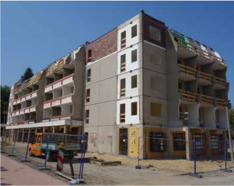
Bauarbeiten in der Rosengasse
