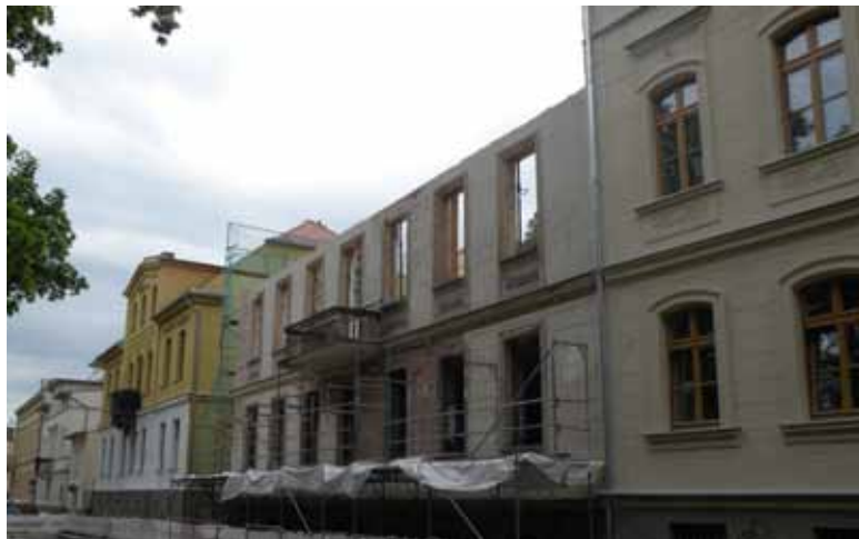
Halbe Stadt 23-24 - das Dach der Nr. 23 war aufgrund der Schäden nicht zu retten
