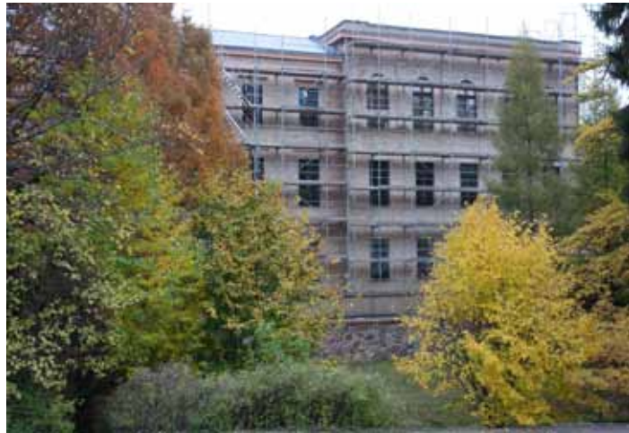
Die eingerüstete Bürgerschule
