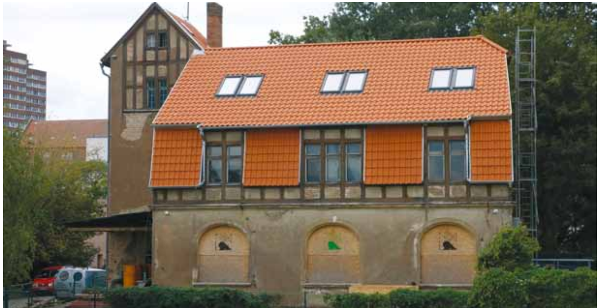
Das alte Pumpenhaus in der Klingstraße mit neu gedecktem Dach
