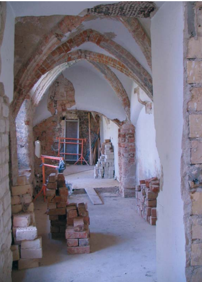
Gewölbegang im EG Forststraße 1 BILDARCHIV UDB
