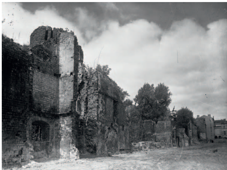
Stadtmauerreste vor dem Abriss
