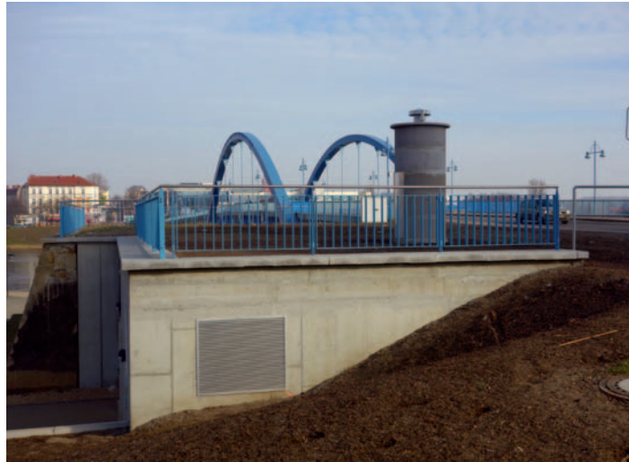
Die Station kurz nach dem Bau
