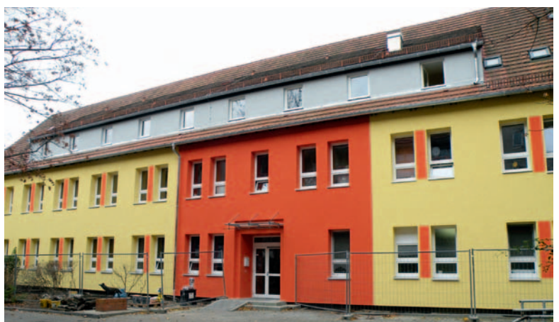
Nordfassade nach Sanierung
