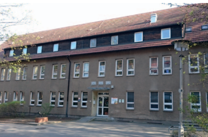
Nordfassade vor Sanierung
