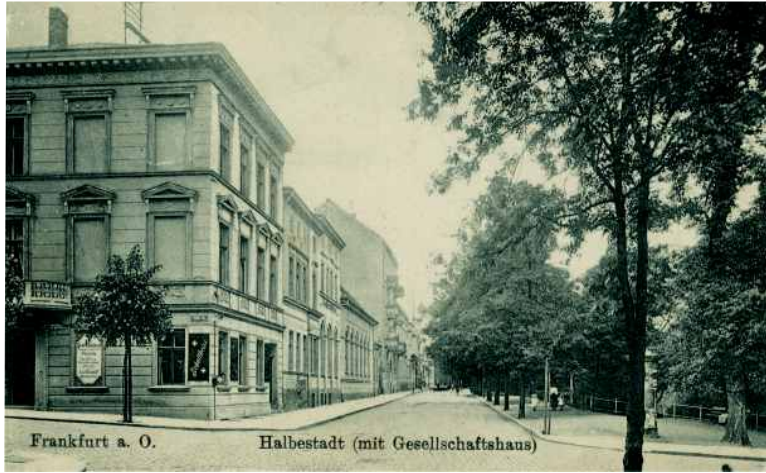
Halbe Stadt, Ecke Breite Straße (heute Rosa-Luxemburg-Straße) mit Blick nach Norden um 1920- Das Eckgebäude steht heute nicht mehr
