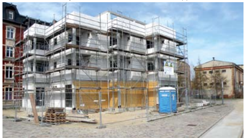
Rohbau der zukünftigen Pension
