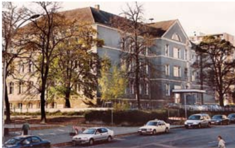
Das Gebäude vor...
