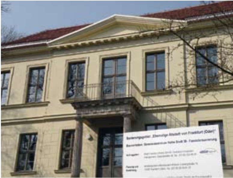
Eine der ersten Villen der Straße erstrahlt in neuem Glanz
