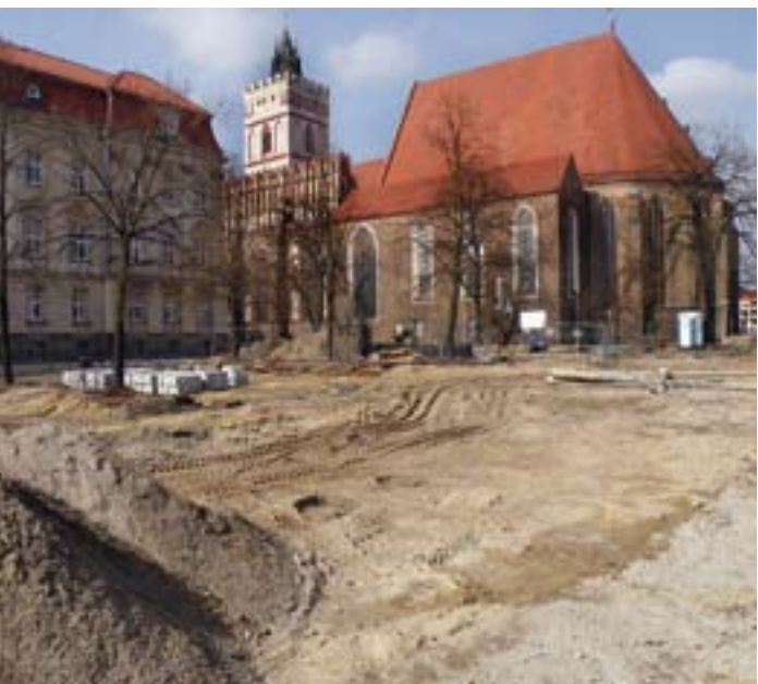
Bauarbeiten auf dem Universitätsplatz
