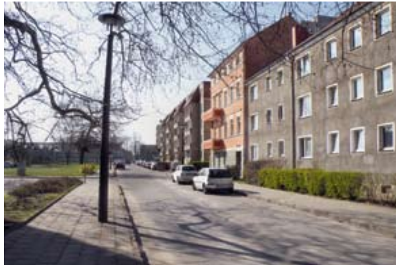
Die Schulstraße muss erneuert werden
