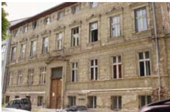
Das Gebäude vor...
