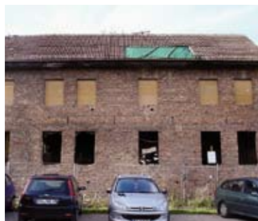
Das Gebäude in der Faberstraße vor und nach der Sanierung
