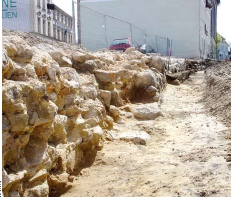
Ansicht der Stadtmauer in der Faberstraße
