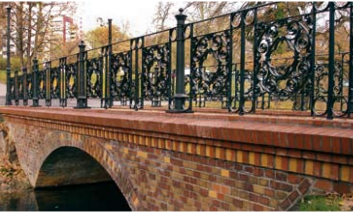
Die sanierte Schwanenbrücke
