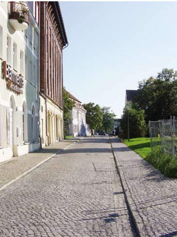
Neues altes Pflaster in der Faberstraße
