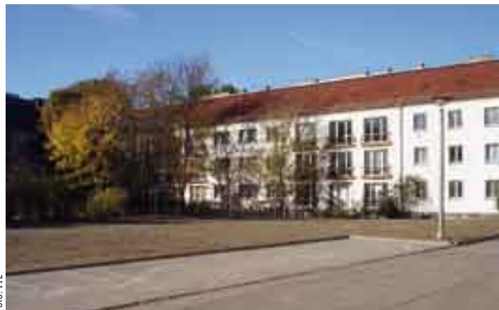
Abrissfläche in der Wollenweber Straße
