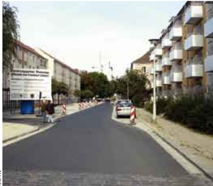
Fahrbahn fertig, die Fußgänger müssen sich noch gedulden
