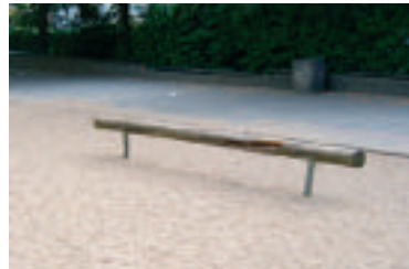
Dringend sanierungsbedürftig – Spielplatz an der Promenadengasse
