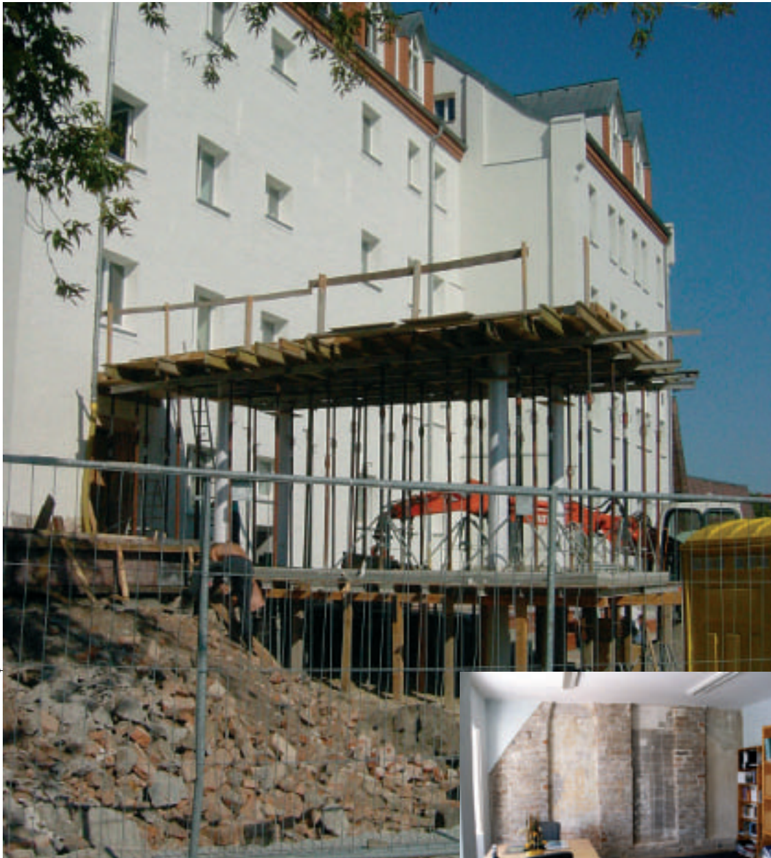
Baustelle – Wintergarten-Café am Haus IV
