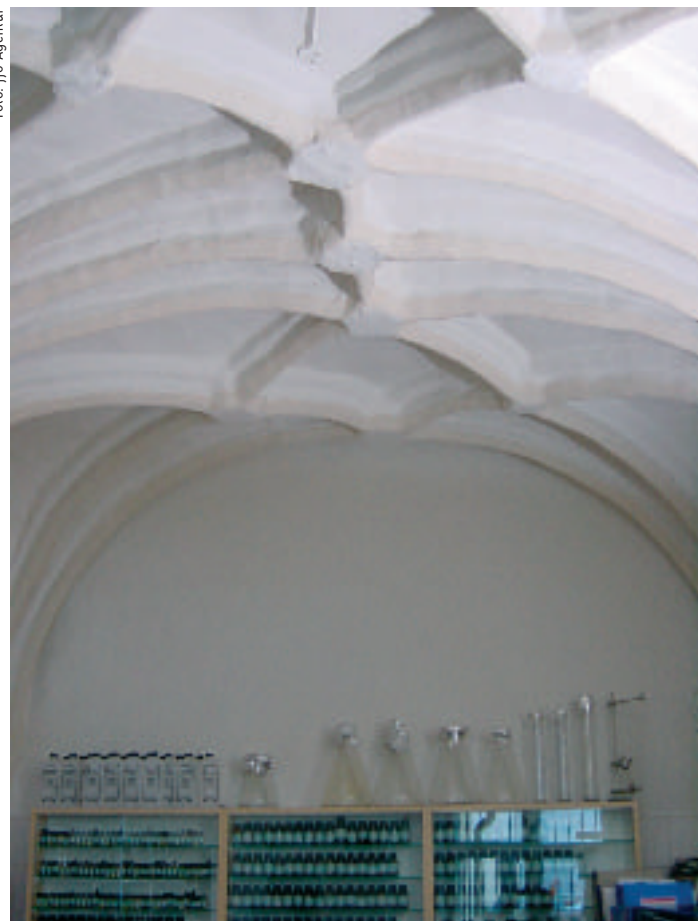
Gewölbe im Labor der Apotheke
