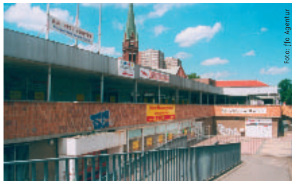
Über 10 Jahre dauerte der Bau des ehemaligen Konsument-Kaufhaus
