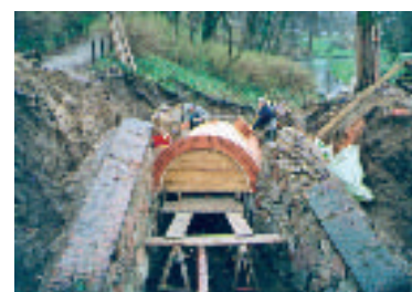
Neuaufmauerung des Brückengewölbes im Frühjahr diesen Jahres
