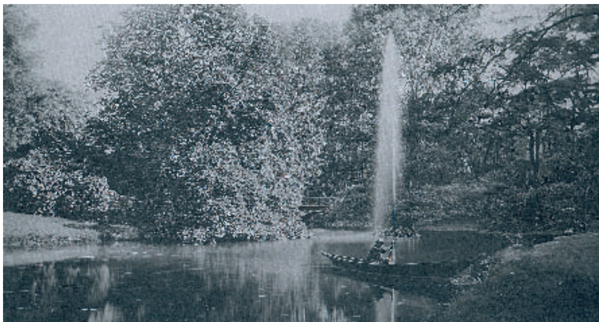
Blick über das Wasserbassin mit Fontäne auf die Schwanenbrücke (Aufnahme 1893)
