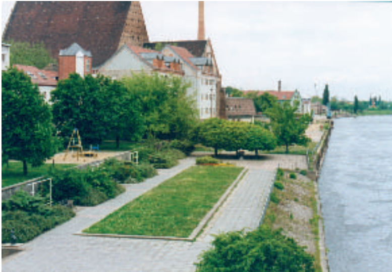
Promenade nördlich der Stadtbrücke vor Neubau der Hochwasserschutzmauer
